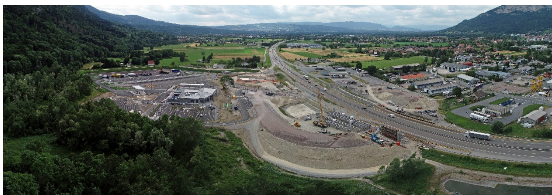
Le chantier de la nouvelle aire bidirectionnelle à Bonneville
