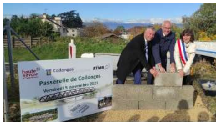
Pose de la première pierre © ATMB
