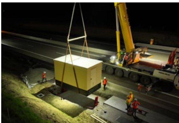
▲ Les shelters et les poteaux qui supportent le portique ont été posés en amont.
