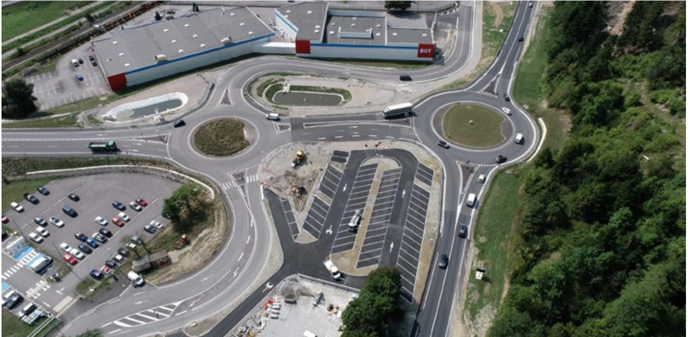
▲ Les travaux de la Maladières se sont achevés en août 2025 après 18 mois de travaux.
