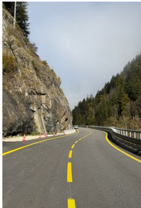
▲ Après 4 années de travaux, le défilé a vu sa sinuosité réduite.
