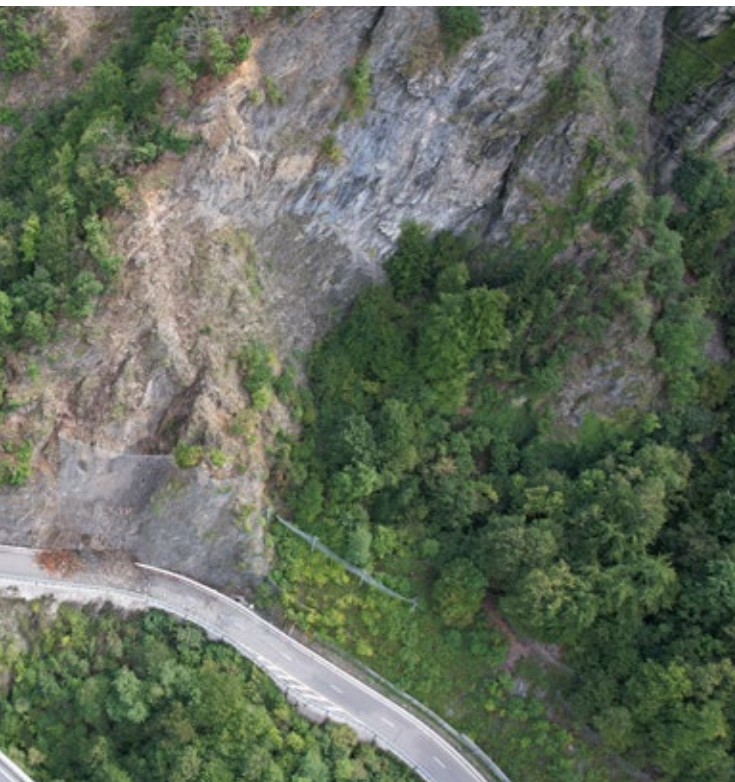
▲ La zone concernée par les travaux, après la purge de la paroi rocheuse.
