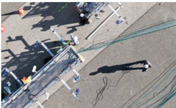
▲ Les portiques ont été équipés au sol avant leur pose.
