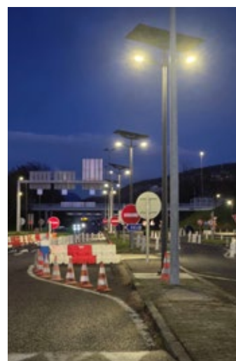
▲ Éclairage solaire sur la plateforme douanière de Vallard.
