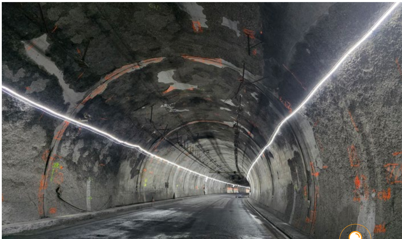
▲ L'intérieur du tube impacté par l'incendie du camion en juin 2025.
