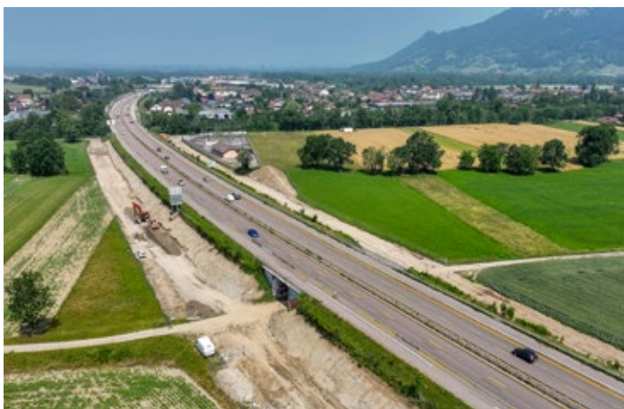
▲ Les travaux pour la captage de Bajolet, situé sur la commune de Saint-Pierre-en-Faucigny.
