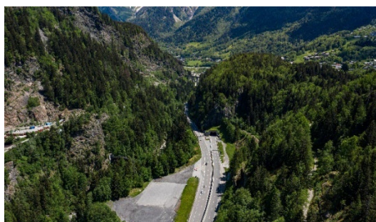
Tunnel des Chavants©ATMB
