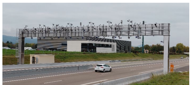
Premier portique Flux Libre à Saint-Pierre-en-Faucigny posé en octobre dernier ©ATMB
