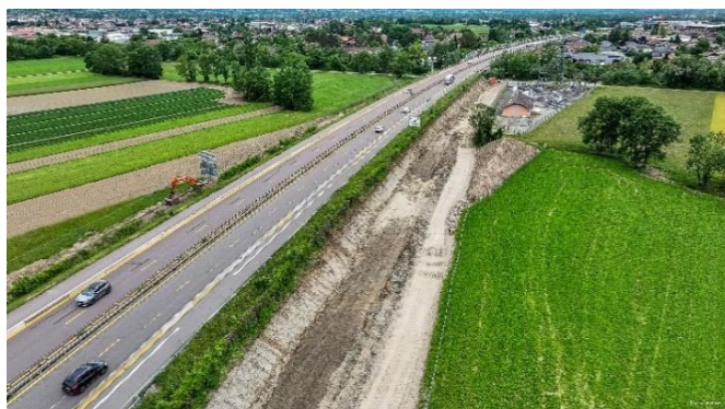
Chantier de protection des zones de captage d'eau potable de Bajolet ©Kara Drone ATMB
