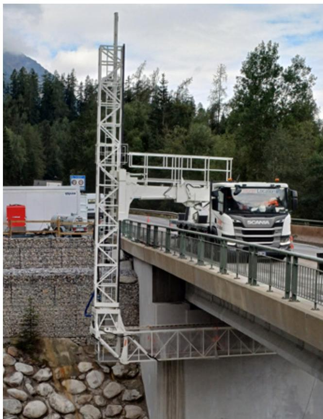
▲ Dispositif permettant aux ouvriers de travailler en sécurité sous le pont de la route d'accès au Tunnel du Mont Blanc.
