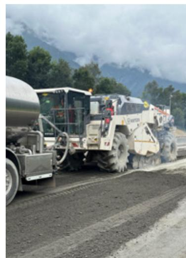
▲ Travaux au rond-point de la Vigie à Chamonix. Phase de retraitement de la chaussée, avec un liant hydraulique.
