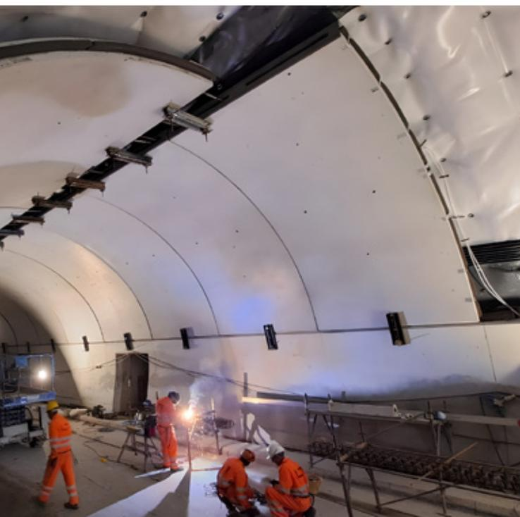
▲ Pose des éléments de voûte préfabriqués et clavage.
