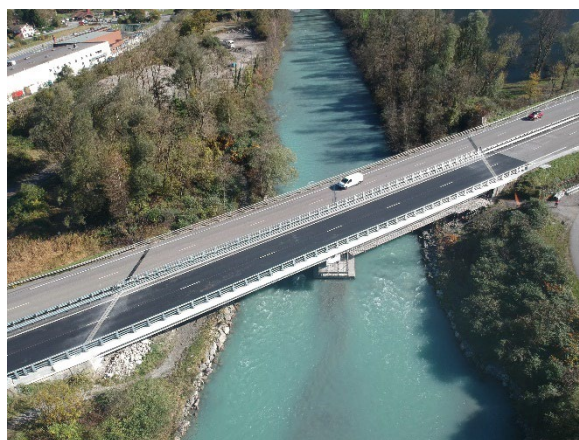
Pont autoroutier Magland ©ATMB
