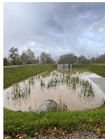
Bassin de rétention©ATMB
