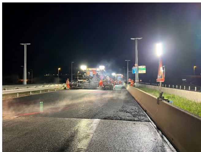
Renouvellement de chaussée©ATMB
