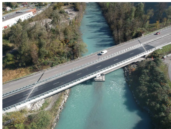
Pont autoroutier Magland ©ATMB
