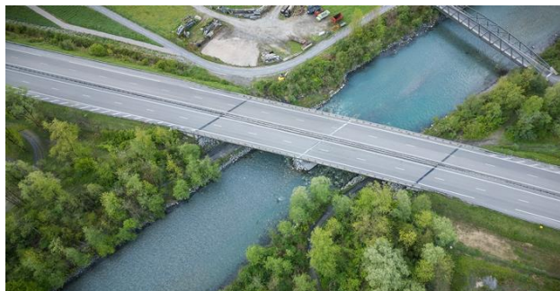
Pont autoroutier à Magland ©ATMB
