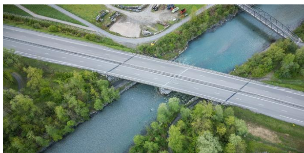
Pont autoroutier à Magland©ATMB
