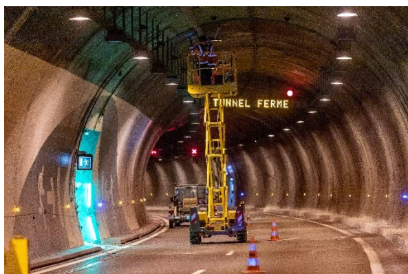
Tunnel du Vuache©ATMB
