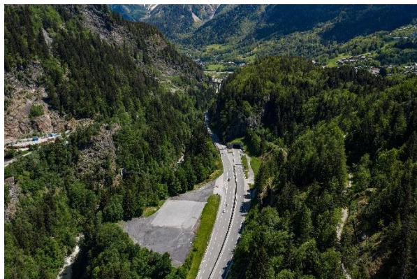
Tunnel des Chavants©ATMB
