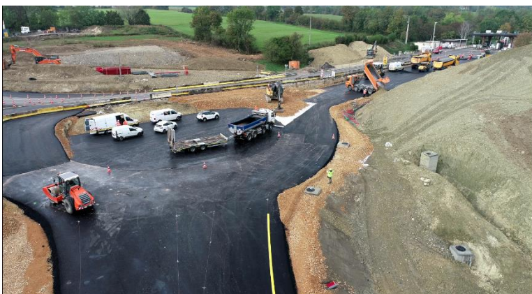
Diffuseur de Bellegarde©ATMB
