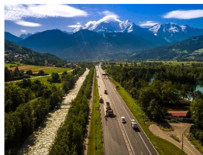
Travaux d'enrobé sur l'Autoroute Blanche.
